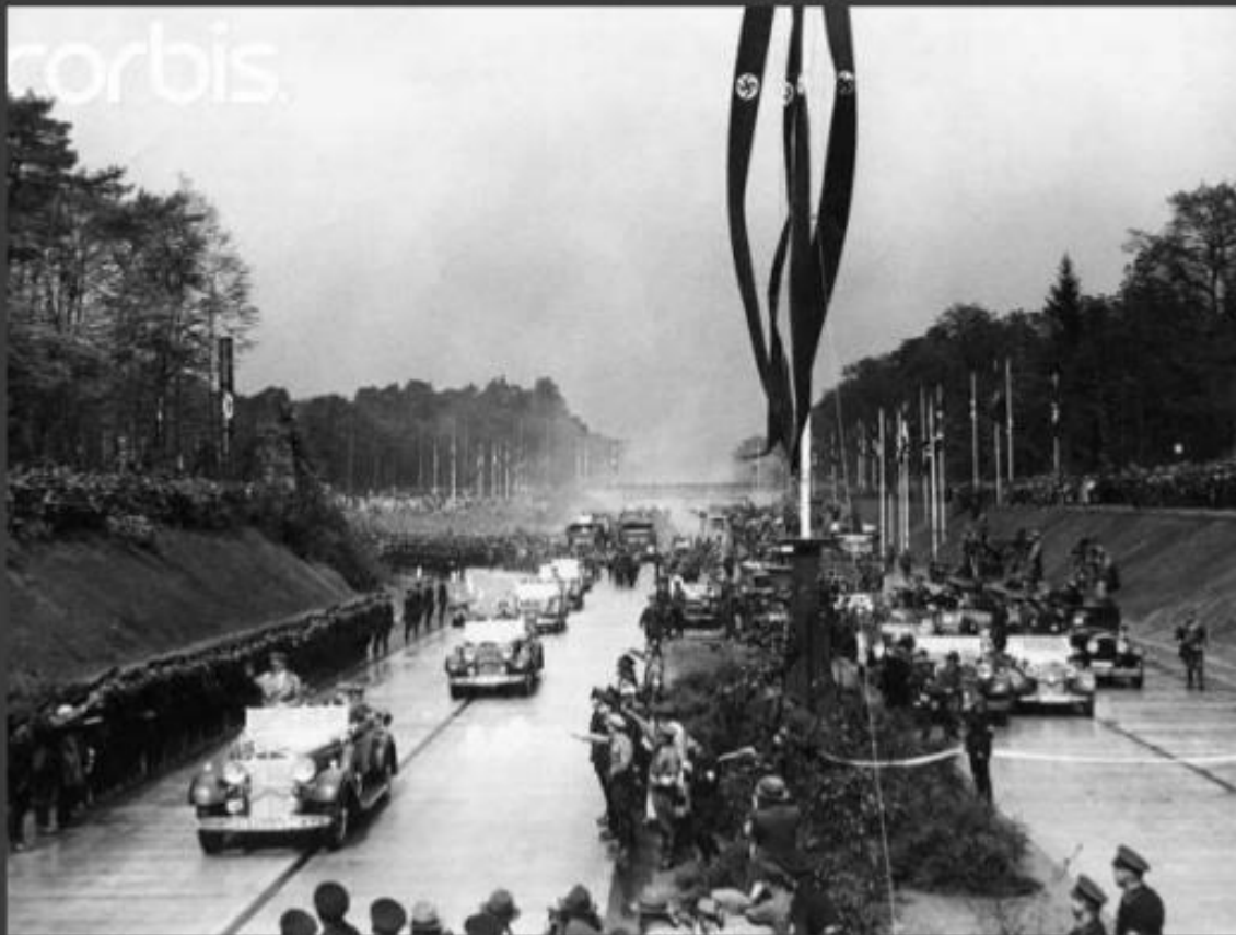
Uusi autobahn avataan
