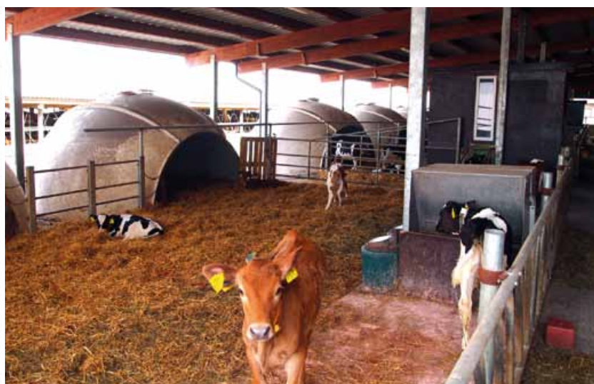
Kuva 11. Iglukasvatuksen vähimmäisvaatimuksena on, että iglujen sijoitusalue on katettu ja sen pohjarakenne on kiinteä, jotta lannanpoisto ja alueen yleinen puhtaanapito toimivat sujuvasti. Suojakatos voidaan toteuttaa pilari-palkki-rakenteena itsekantavalla profiilipellillä. Katoksesta voidaan tehdä varusteltu kiinteä kasvatusympäristö, jossa on tilat yksilö- ja ryhmäiglueille, ruokintapöytä ja juottoautomaatti. Vasikoiden ryhmäytymisessä on otettava huomioon niiden nenäkosketusmahdollisuus jo yksilökarjainavaiheesta alkaen.
