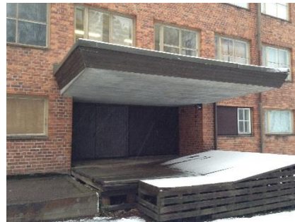
Kuvat: Kudontatilasta kerrostalon puolelle vievä varauloskäynti sisältä ja ulkoa (kuva otettu ennen hätäpoistumistikkaiden lisäystä)
