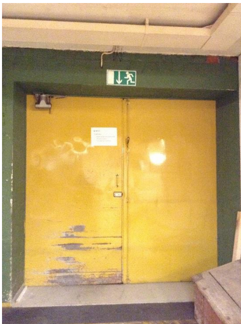
Kuva: Entisöintitilan varauloskäynti, joka vie sisätilojen kautta sisäpihalle ja ovelle 1.
