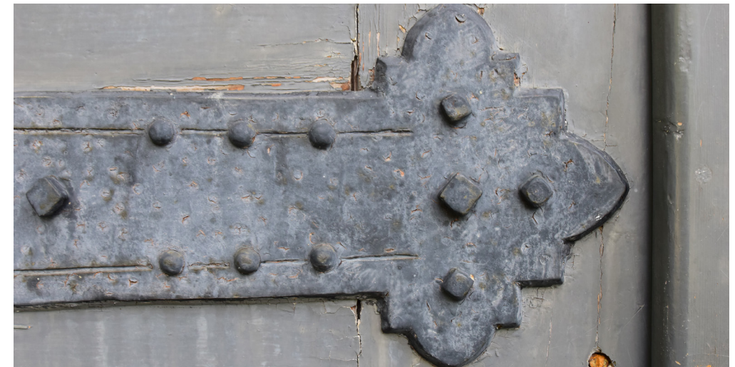
Yksityiskohta Muuruveden kirkon ovesta. Kuva: Eeva Martikainen.
