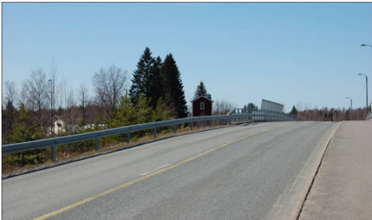
Rautatien ylittävä maantiesilta.
