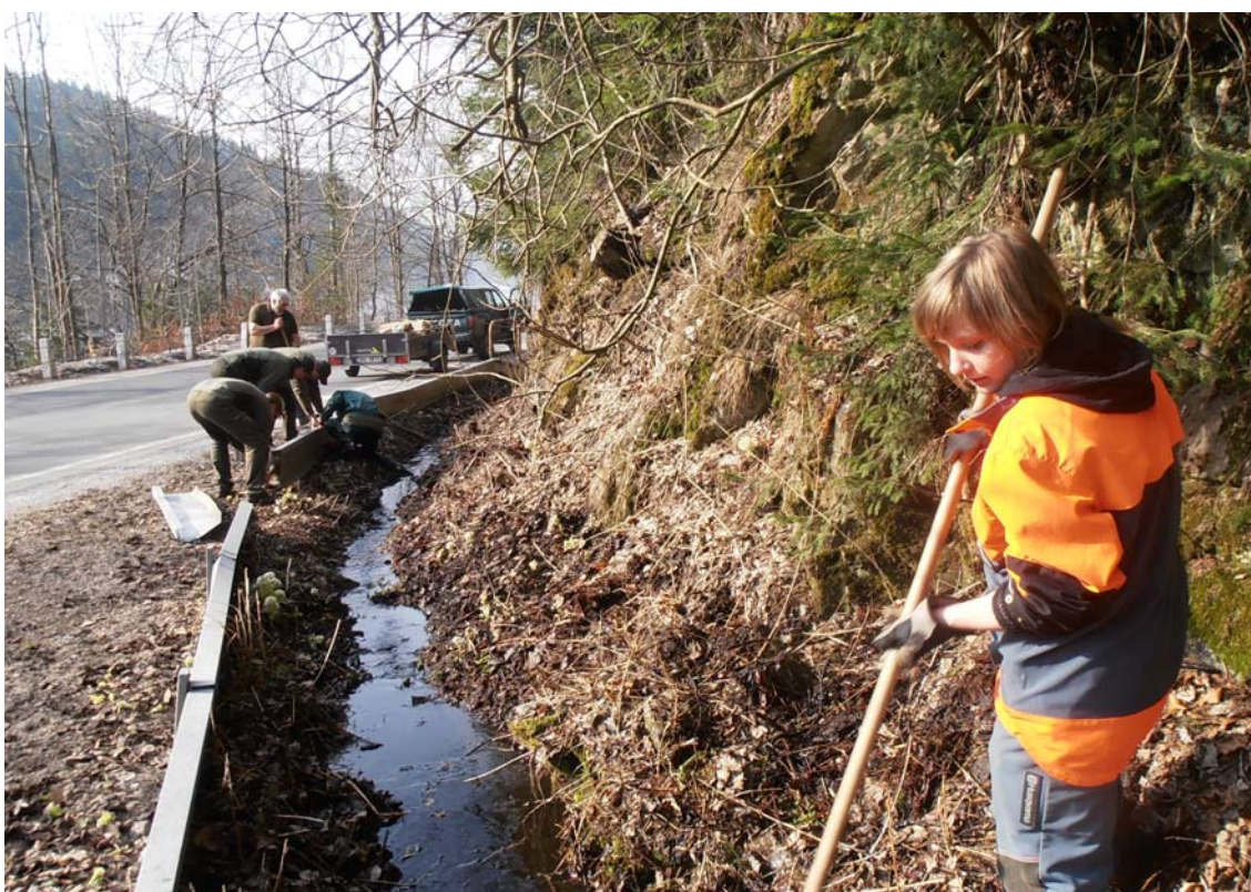
KUVA 2. Suoja-aitojen rakennusta ja ojien kunnostusta kansallispuistossa
