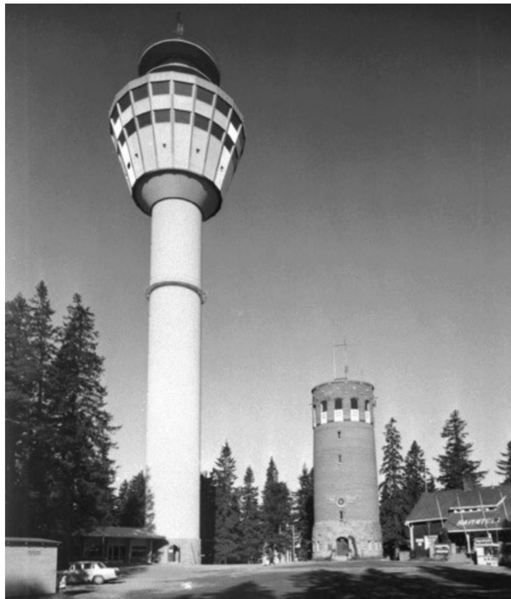
Tässä kuvassa näkyvät Puijon toinen ja kolmas torni vierekkäin. Arkkitehti J. W. Strömbergin suunnittelema, vuonna 1906 valmistunut torni purettiin sen jälkeen, kun arkkitehti Seppo Ruotsalaisen suunnittelema torni valmistui vuonna 1963 Kuva: K. U. Jälänne, Kuopion kulttuurihistoriallinen museo.
