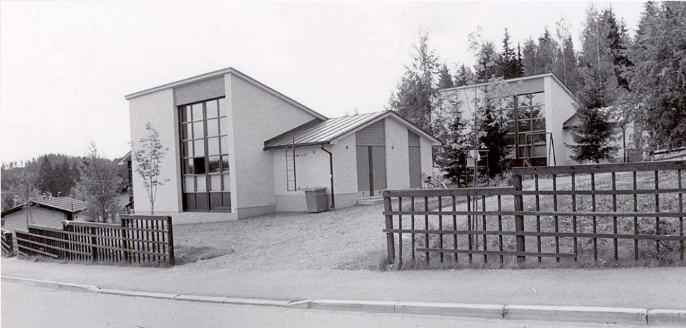
Aapatien varressa sijaitseva ateljeetalo v. 1985. Rakennuksen ateljeeosassa pulpettikatto ja suuret ikkunat. Taina Takala/ Kuopion kulttuurihistoriallinen museo.
