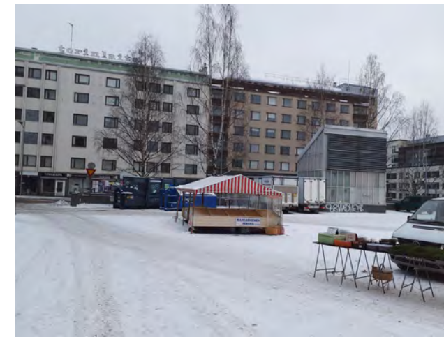
Pysäköintilaitoksen ilmanvaihtolaitteet muodostavat hallitsevan elementin torille.
