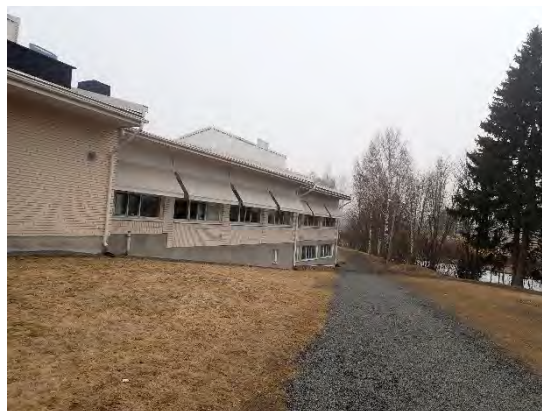
Kuva 3. Kuva rakennuksen vierustalta.
