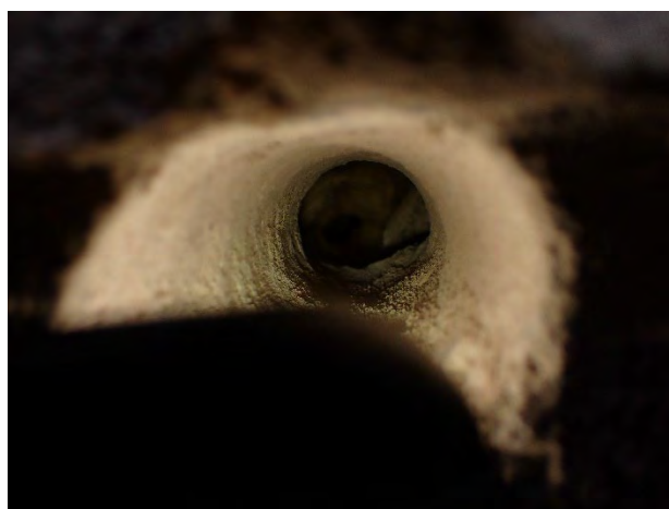
Kuva 31. Kuva rakenneporauskohtasta RA 4us.
