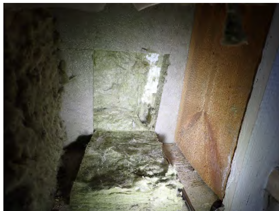
Kuva 30. Kuva rakenneavauskohdasta RA2.
