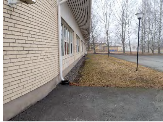
Kuva 5. Kuva rakennuksen vierustalta.
