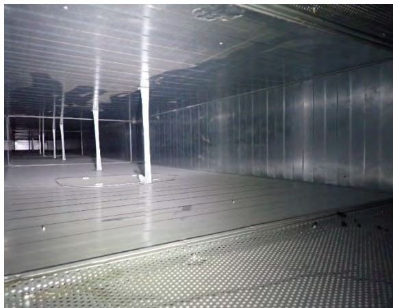
Kuva 71. Kanava osin puhdistettu.
