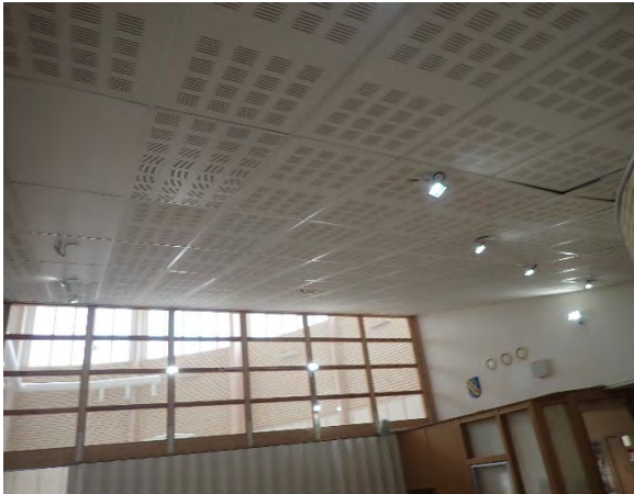
Kuva 56. Yleiskuva yläpohjan alapinnasta.
