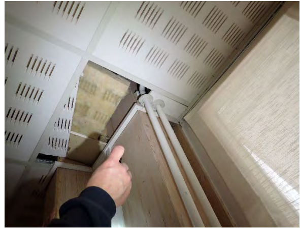
Kuva 57. Levyn takana mineraalivillaa.
