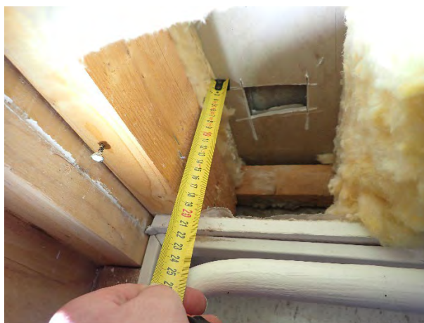
Kuva 29. Kuva rakenneavauskohdasta RA1
