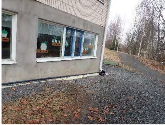
Kuva 4. Kuva rakennuksen takapihan puolelta.
