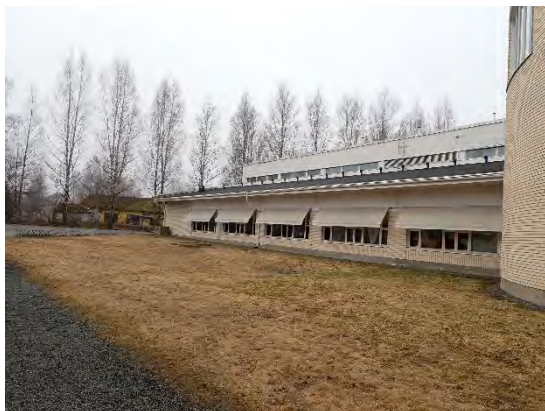
Kuva 2. Kuva rakennuksen takapihan puolelta.
