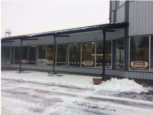
Julkisivu Lähipuoti Remeksen varastotiloista Humppilassa.
