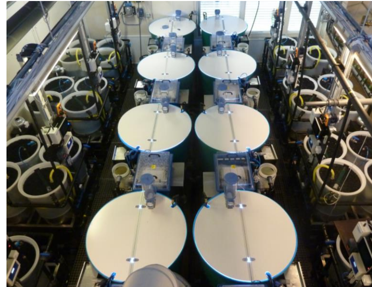
Laukaan koelaitoksen kiertovesiyksiköt Kuva: Tapio Kiuru
